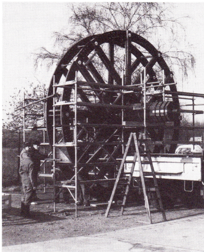
Das neue Wasserrad der Holzlarer Mühle auf dem Gelände des Technischen Hilfswerks Beuel
