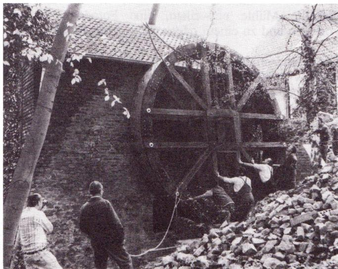
Langsam und vorsichtig wird das Wasserrad in den Mühlengraben hinabgelassen, bis die quadratische Öffnung in der Mitte des Rades sich exakt vor der Öffnung in der Wand im Kellergeschoß der Mühle befindet.
