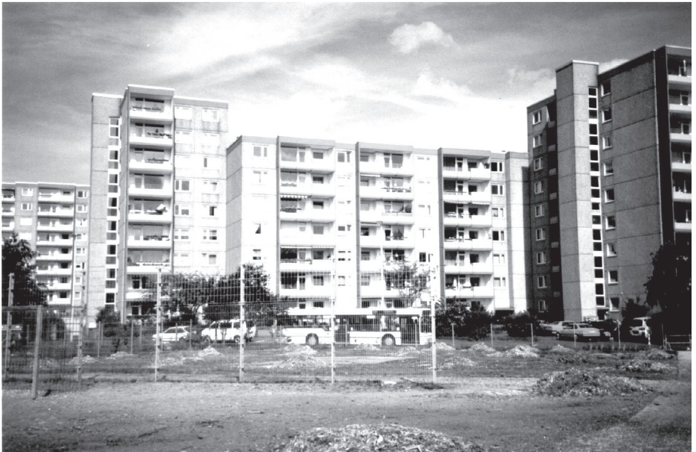
Hochhäuser am Finkenweg in Kohlkaul.
