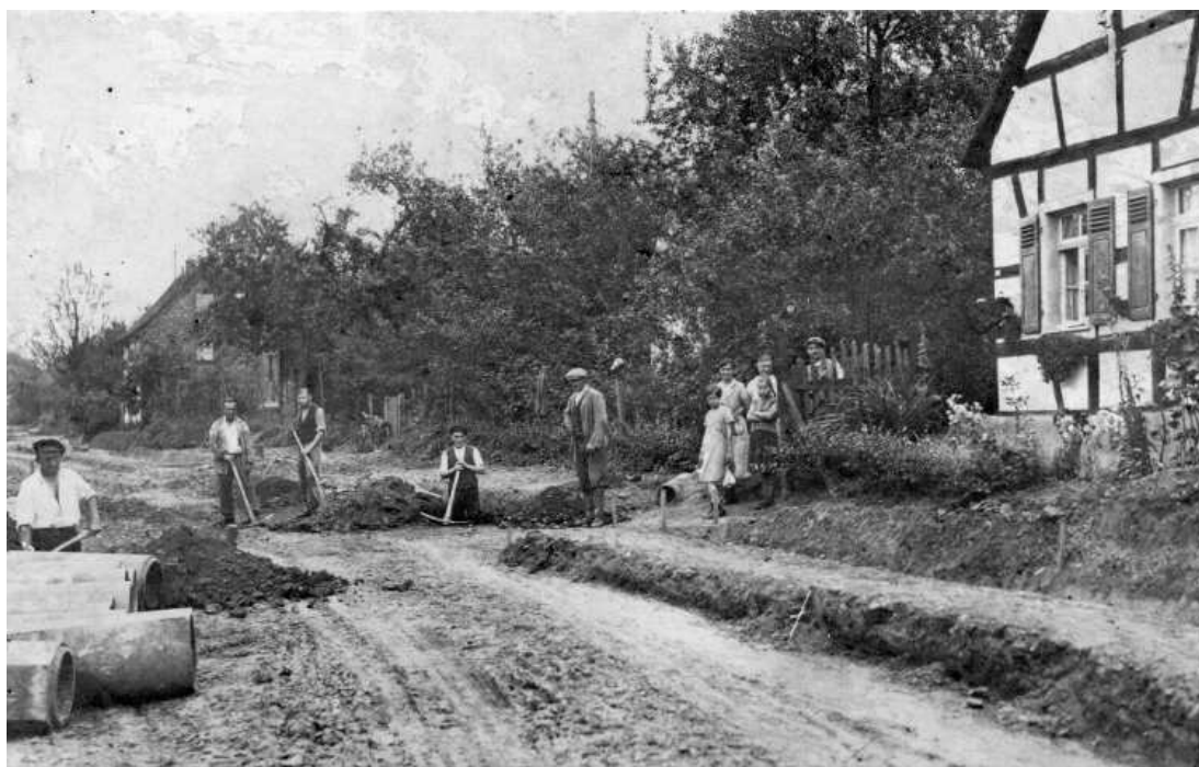
Straßenbauarbeiten an der unteren Hauptstraße (Rechts im Bild die Bäckerei Adler)
