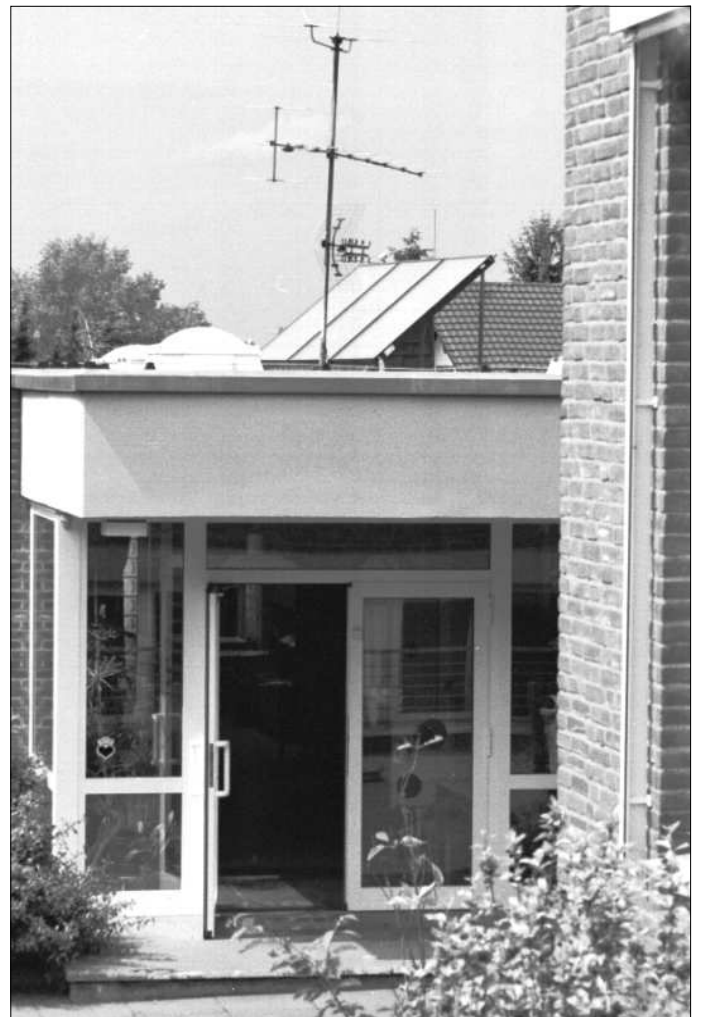
Solaranlage auf dem Dach des Evangelischen Kindergartens Bonn-Holzlar
