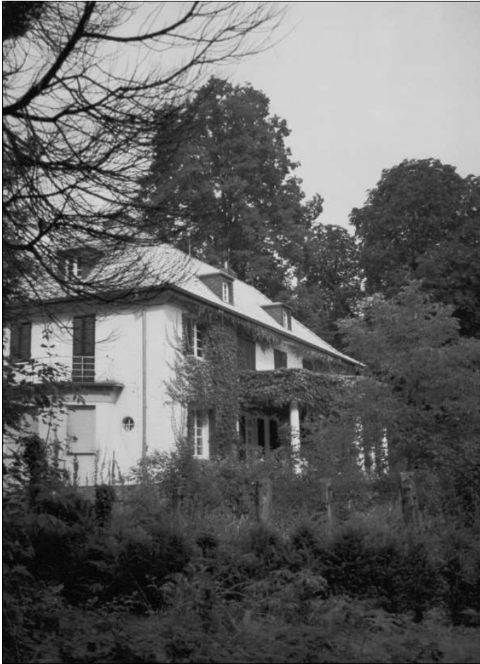
Das Hauptgebäude von Gut Eichthal (Gartenseite), aufgenommen am Tag der offenen Tür am 18.7.2004
