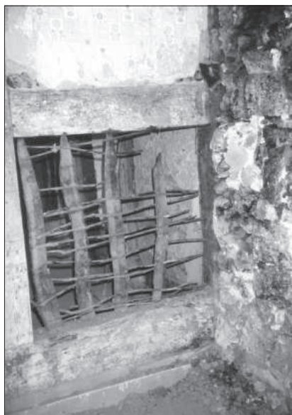
Klassische Lehmausfachungen mit Eichengestake und Weidenrutengeflecht, das dann mit Lehm-/Stroh-Gemisch beworfen wurde.
