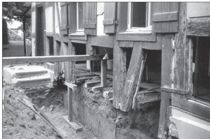
Schwellbalken des Ostgiebels und morscher Sockel müssen erneuert werden.
