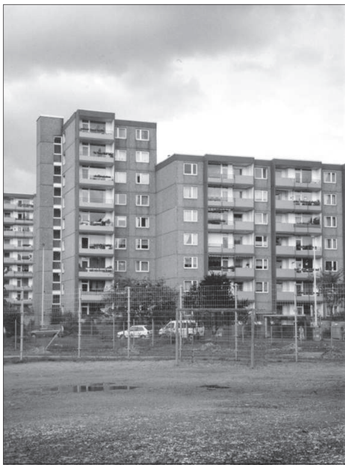
Hochhäuser am Finkenweg
