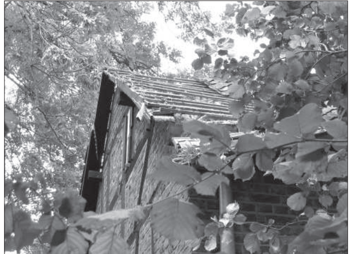
Die Holzlarer Mühle - zum Teil abgedeckt
